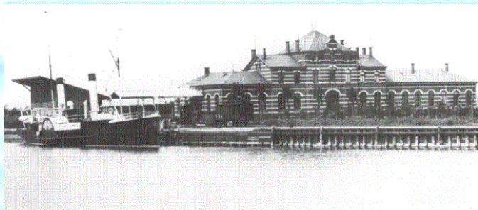
Alter Bahnhof Warnemünde mit Umstieg, Postdampfer im Hafenbecken 1886
